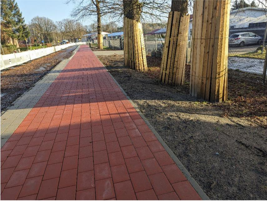
Über die gesamte Baustrecke wurde der Radweg entlang der B 71 neu hergestellt. In diesem Zuge wurden die Parkstreifen entlang des Radweges umgestaltet sowie die Bushaltestellen nacheinander erneuert. Teilweise wurde ein neuer Regenwasserkanal verlegt und die Entwässerung teils mit neuen Straßenabläufen hergestellt.
